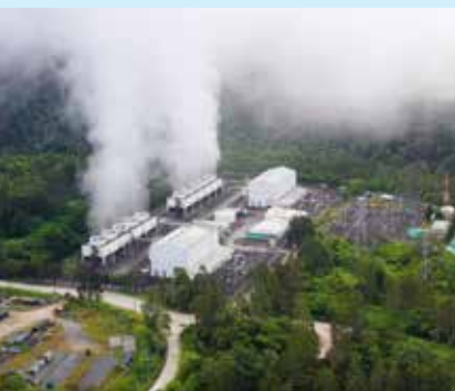
Centrală geotermală în Filipine
