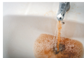
Figura 1. Apă de la robinet, tulbure și murdară
